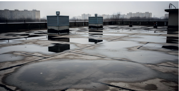
Rénovation de toit plat
