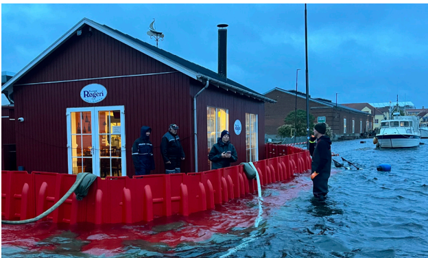
Außenecken und gerade Kästen für den Hochwasserschutz entlang der Grundstücksgrenze.
